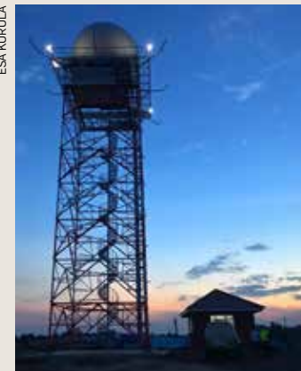
Vaisala toimittaa Etiopiaan säätutkia, joita on jo toiminnassa Ugandassa.
