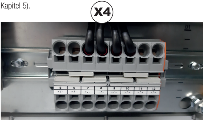
Abb. 6.6 Klemmleiste X4 der Steuereinheit, Anschluss der Elektrolysezellen
