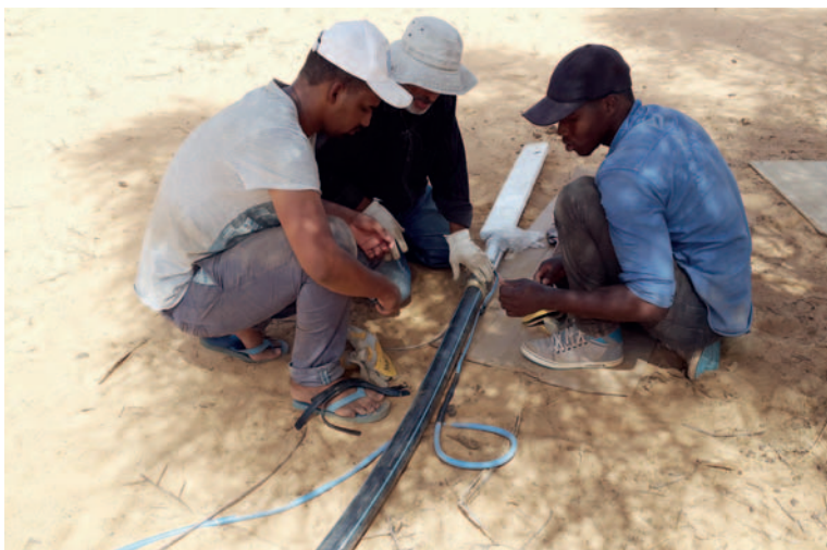
Bauleiter von Solar23 GmbH weist die nigerianischen Bauarbeiter ein
