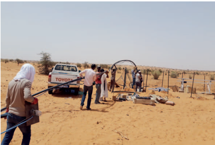
Die SQFLEX wird mit Zuleitung und Verrohrung ins Bohrloch abgesenkt.
